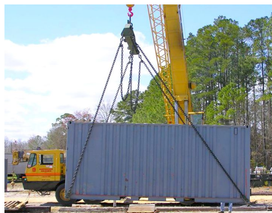
Vyvažování těžiště kontejneru pomocí řetězových úvazků se zkracovacími háky při manipulaci pomocí jeřábové traverzy kontejnerové JTC.
