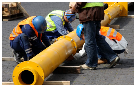
Modulární traverzy mohou být převáženy v rozloženém stavu a smontovány až na místě použití.
