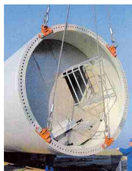
Aplikace speciálního šroubovacího bodu FLABIRO při montáži trubkových segmentů
